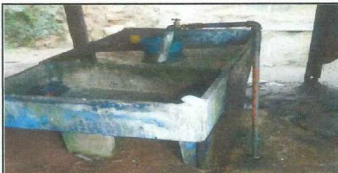
Foto 3: Se observa la necesidad de sustitucion de pila de cemento de un lavadero.
